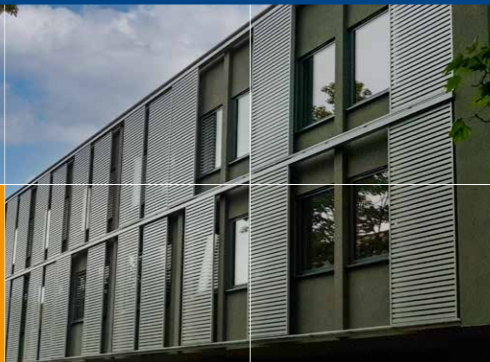
Okiennice przesuwne, które dostosowują się automatycznie do położenia słońca. (na górze) Przepiękne okiennice z cedru kanadyjskiego zdobią fasadę prywatnej rezydencji
